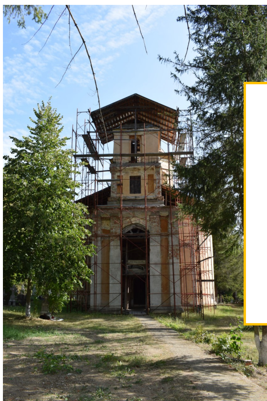
Mănăstirea Râncăciova—restaurare în derulare ; schela și acoperișul temporar de protecție; aspecte din exterior și interior.
