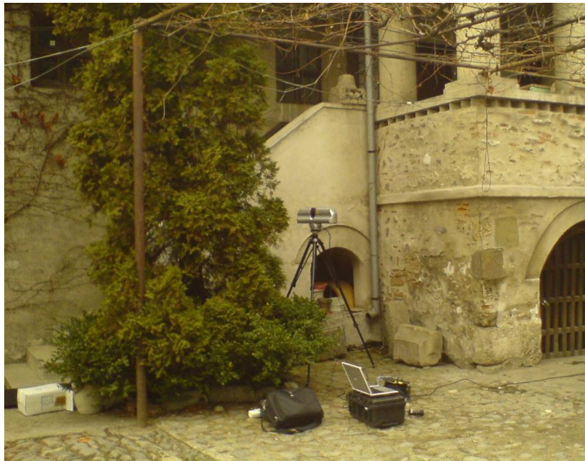
Fig 3 Scanarea fațadei dinspre Turnul Bărăției
