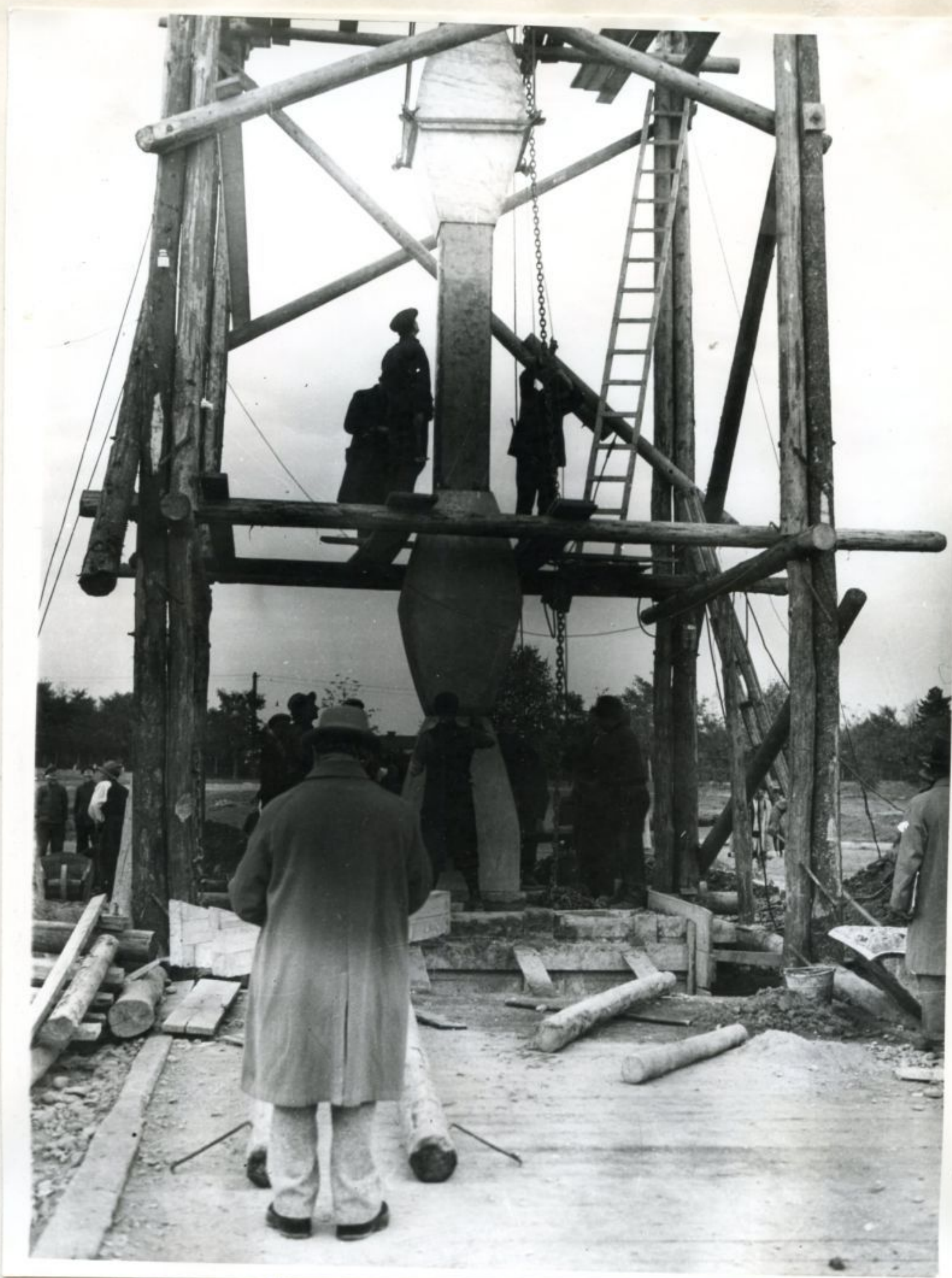
FOTO NR. 4 SE LASA IN JOB CRL DE AL DOILSA ELEMENTE (BRANCUSE CU SPATELE)
