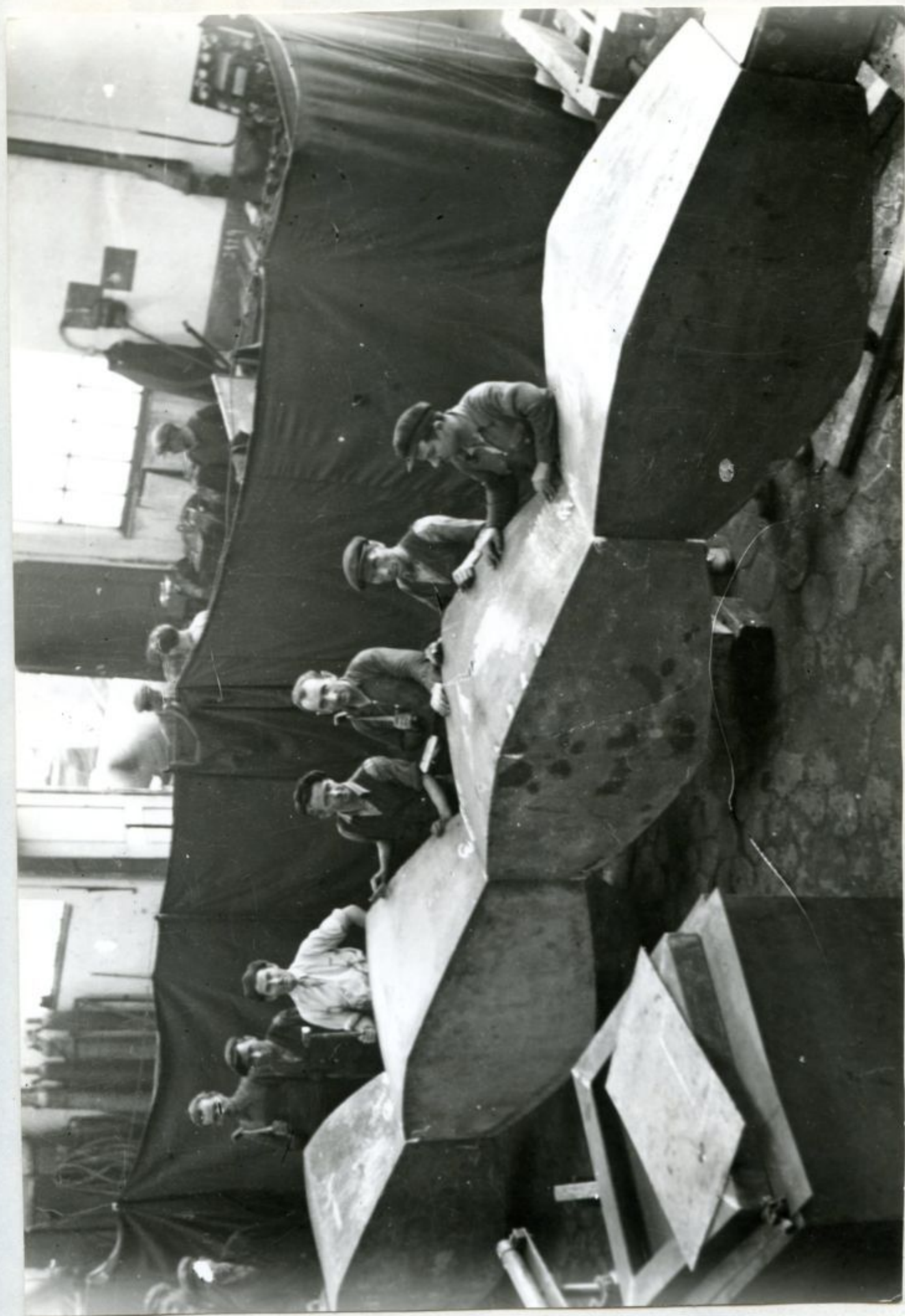
FOTO NR. 7 MONTAJUL DE PROBA AL COILOANTELOR ÎN ATELIERUL DE CONSTRUCȚII METALICE A.C.F. DIN PESTERANI
