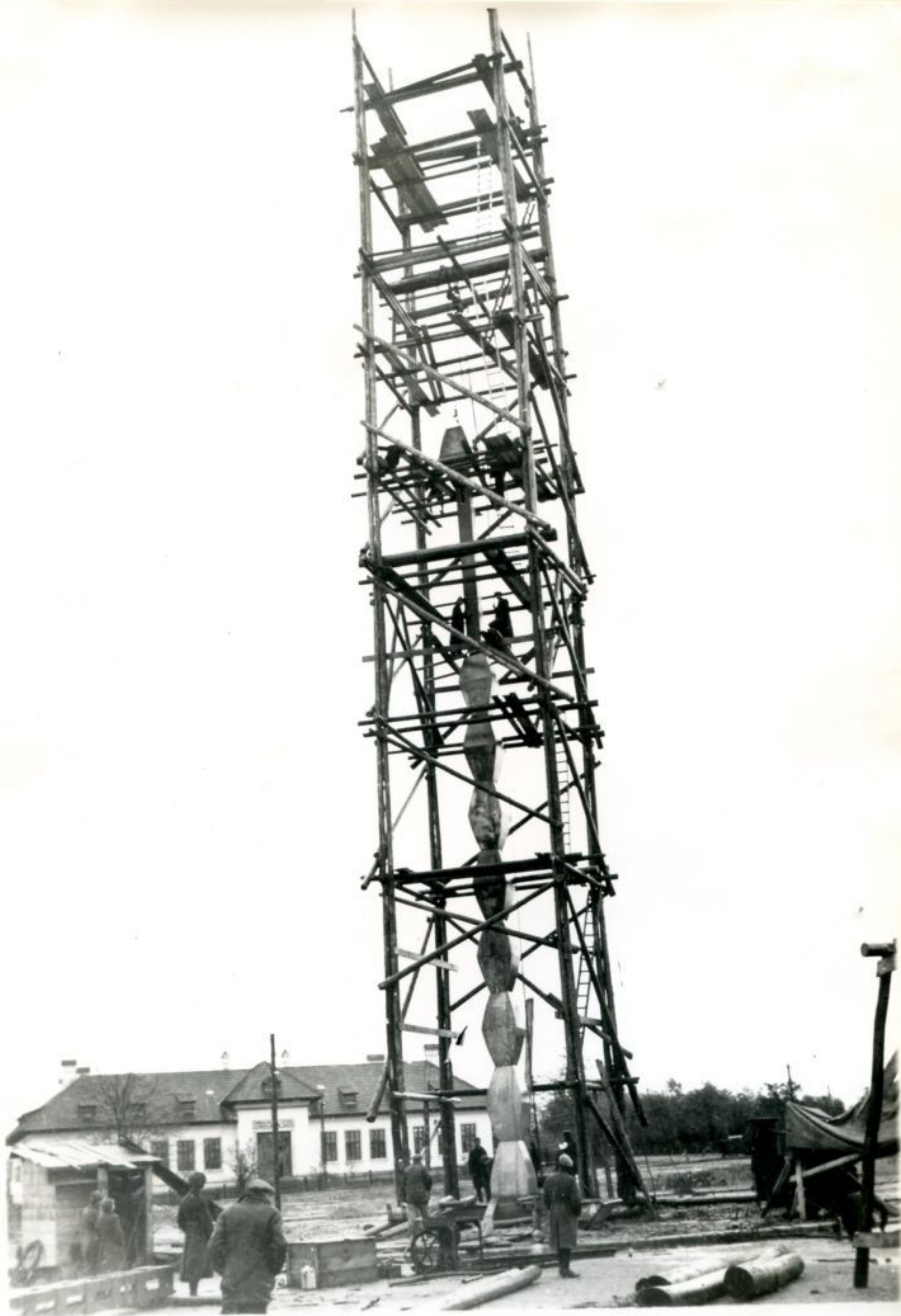
FOTO NR. 6 TRAGEREA PE STILP A CILUI DE AL 8-lea ELEMENT
