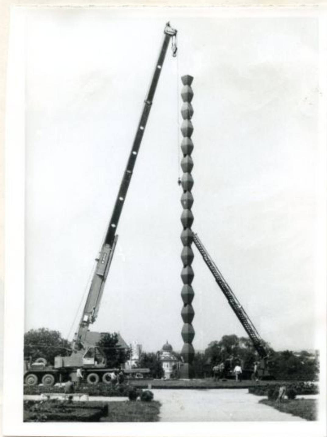
FOTO NR. 9 și 10 - MONTAREA CAPTORILOR SEISMOMETRICI RANGERS SS-1 CU AJUTORUL SCARII DE POMPIERI SI MACARALEI KATO - MITSUBISHI
