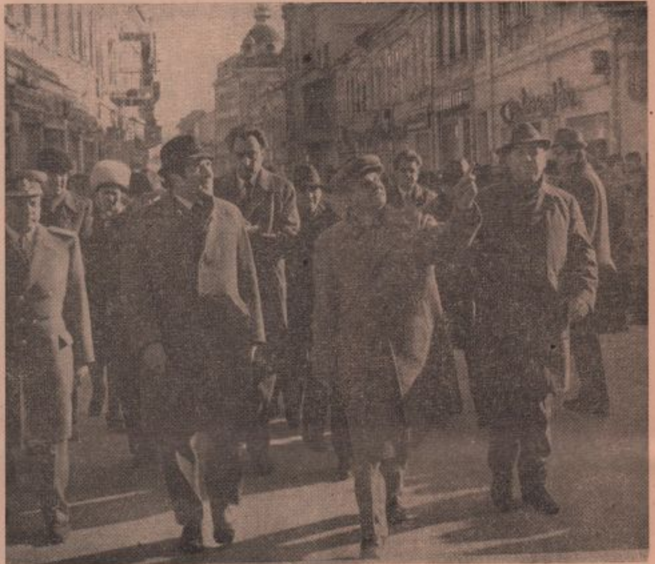
Pe strada Unirii, grav lovită de cutremur.
